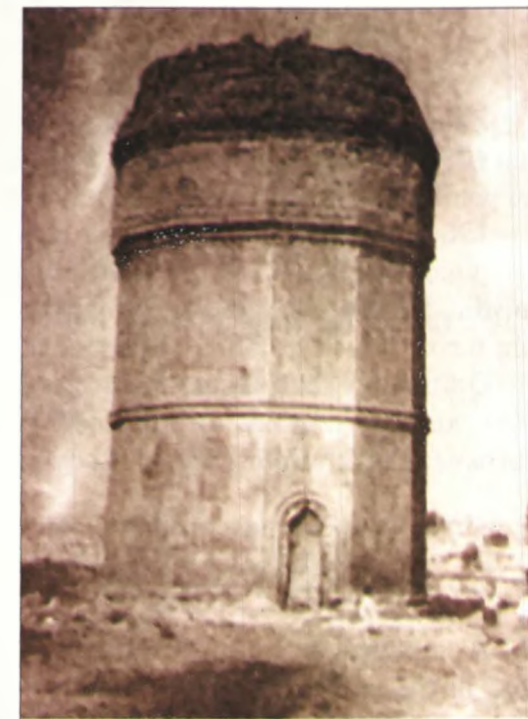
Cəfərabad//Pir Hüseyin türbəsi gümbəzi dağılmış halda.
