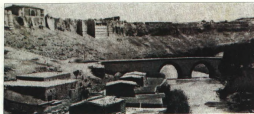
İrəvan qalasının və Sərdar sarayının Zəngi dərəsindən görünüşü.
